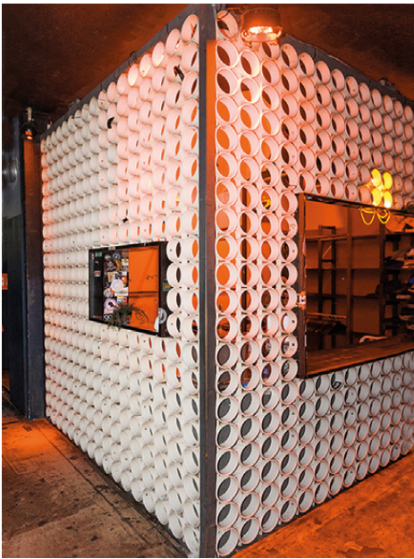
Blick in die Garderobe von »Beate Uwe«. Die Deckenverkleidung des ehemaligen Postamtes dient heute als Raumteiler.
