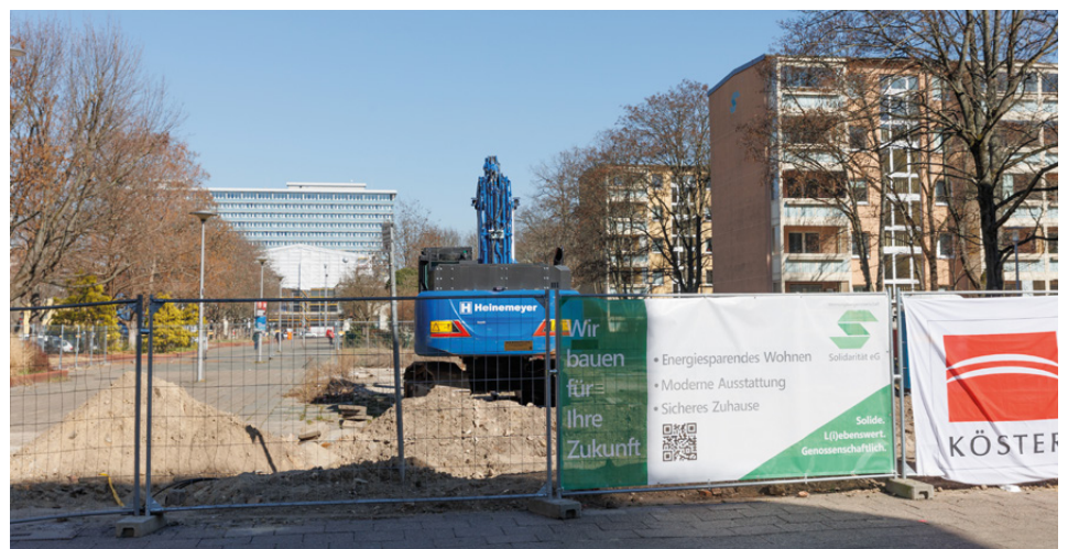
An der Ecke Singer-/Schillingstraße setzte am 12. Februar die Wohnungsbaugenossenschaft Solidarität den Spatenstich für ein Wohn- und Geschäftshaus.
