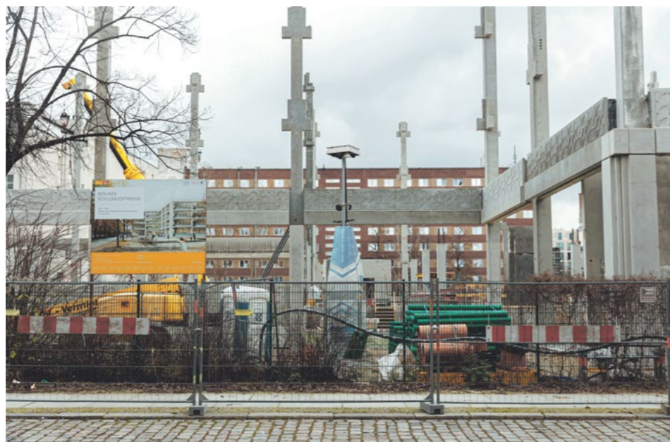
Dieser modulare Neubau einer vierzügigen Grundschule mit Sporthalle entsteht bis Schuljahresbeginn 2024/25 an der Ecke Adalbert-/Melchiorstraße.
