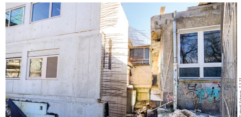
Der Rohbau des Sportgebäudes in der Charlotte-Pfeffer-Schule ist abgeschlossen. Derzeit beginnt der Innenausbau.
